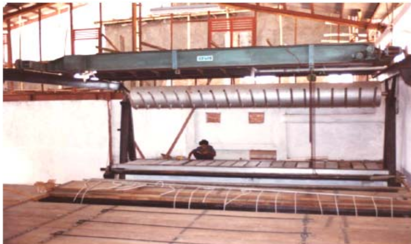
Overhead Gantry Crane dan Ice Can Filler yang dapat mengisi air untuk 20 cetakan es bujur sangkar ukuran 25 kg sekaligus, pada Pabrik es balok dengan kapasitas 50 metric tons /24 jam di Pekalongan, Jawa Tengah.
